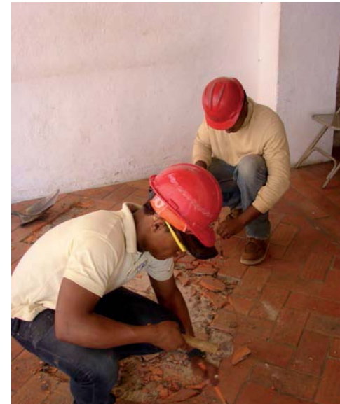
Estudiantes del Taller de Albañilería Reparando piso de Galería Norte
