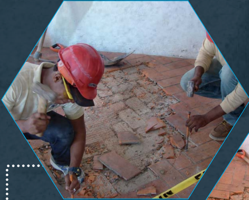
Levantamiento de baldosa.
