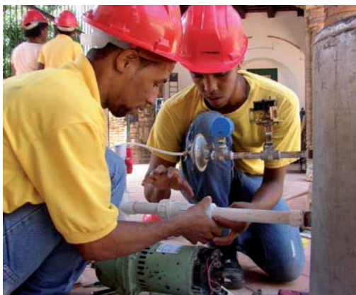
Estudiantes de Fontanería y Electricidad Reparando Bomba Hidráulica
